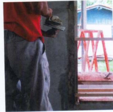
Foto 2: Preenchimento, com argamassa, do vão entre o contra-marco e a alvenaria.
