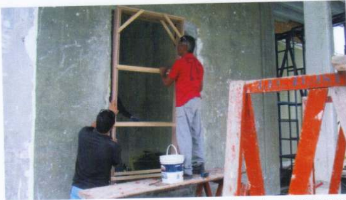
Foto 1: Ajuste do contra-marco de madeira, travado e contraventado
