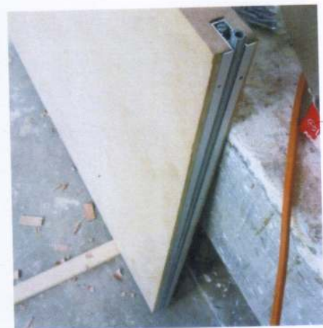
Foto 6: Detalhe do elemento de vedação instalado na travessa inferior da folha de porta
